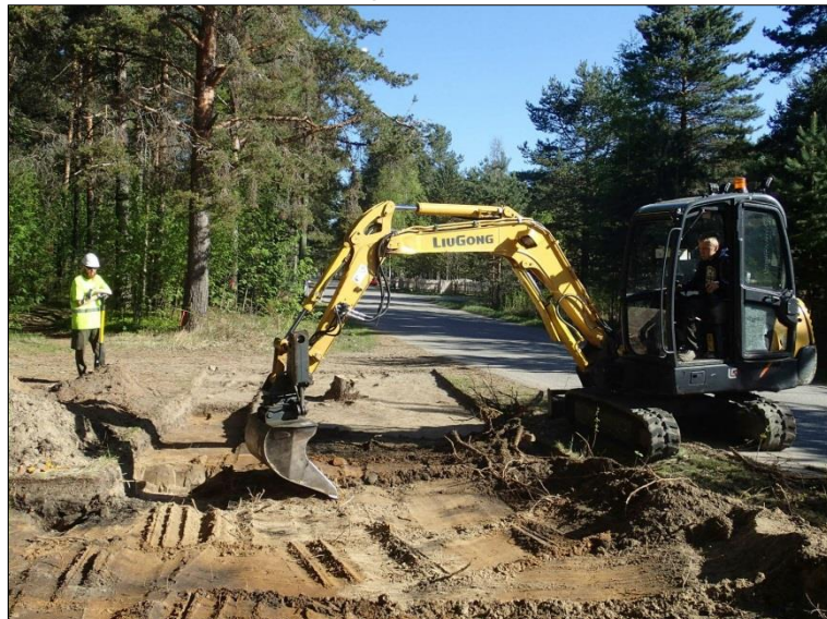
Kaivausalueen pintamaita poistetaan koneellisesti.
